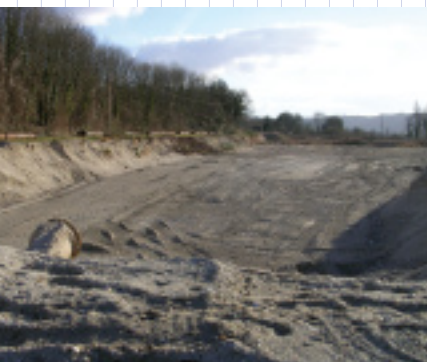
Casier d'un site de dépôt en exploitation
