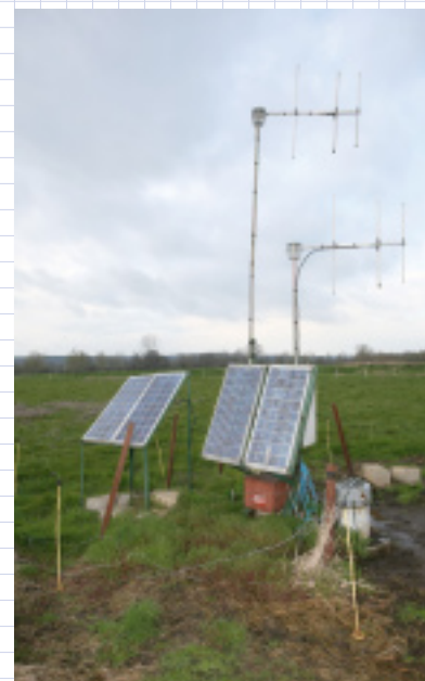
Piezomètre pour le suivi de la nappe autour des sites de dépôts
