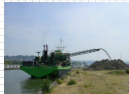
La drague CHARLEMAGNE en opération à Rouen pour le chantier du pont FLAUBERT (6 ème franchissement)
