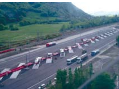
Terminal Modalohr : système permettant de transporter les camions sur le réseau ferré
