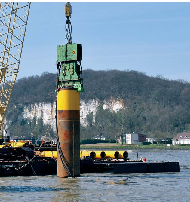
Le poste d'attente et de sécurité de Vatteville-la-Rue pourra être utilisé par une large palette de navires : caboteurs, handymax voire overpanamax
